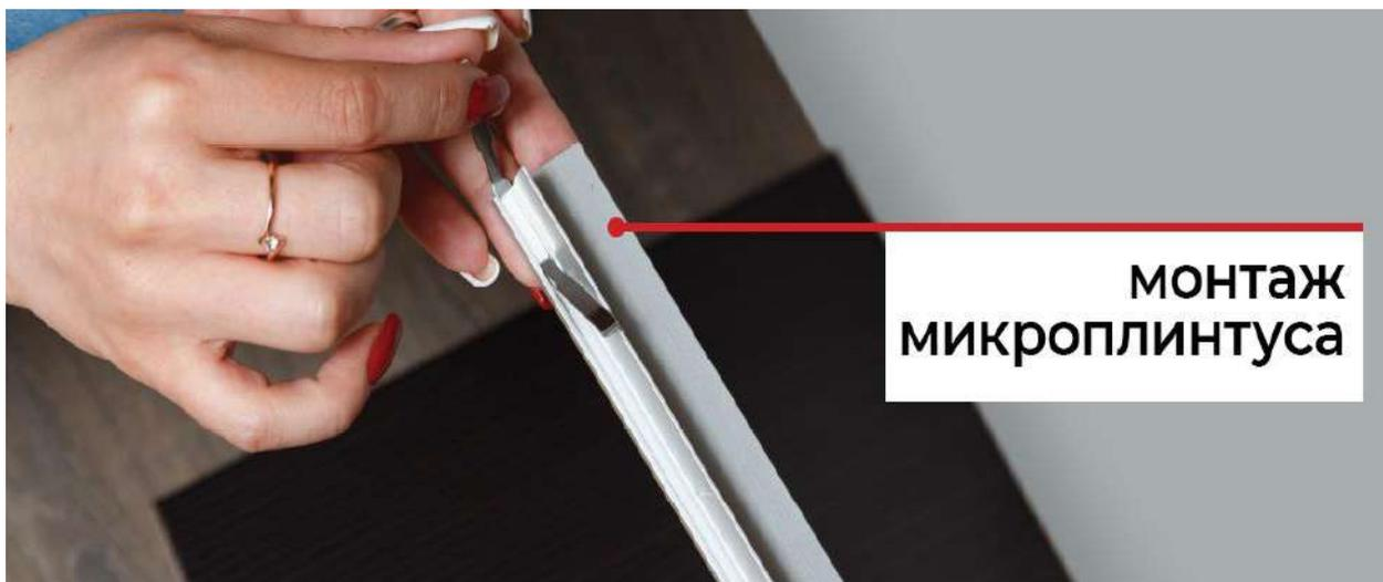
Сама установка микроплинтуса не доставит трудностей. Монтаж происходит на отжимные клипсы из рессорной стали, которые удерживают его в зазоре между стеной и полом. Стоит отметить, что микроплинтус, подходит для всех напольных покрытий, толщина которых не тоньше 5 мм.
